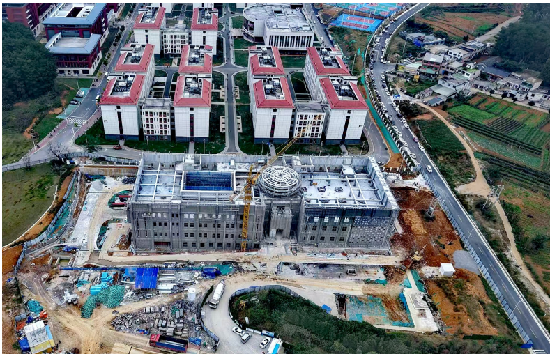
贵州省考古标本库房建设项目现场
