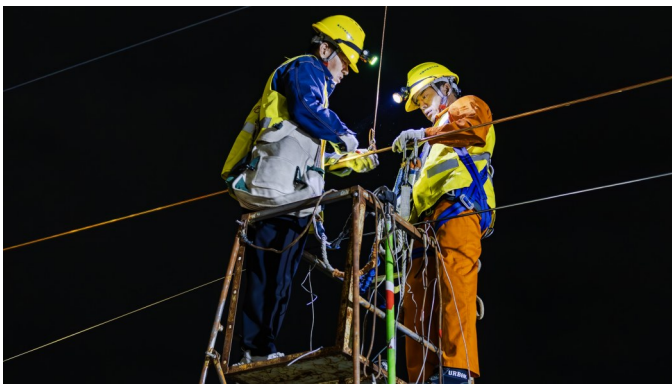
铁路职工正在为渝贵铁路修文县站更换接触线
