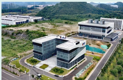
国家电投集团贵安数据中心
