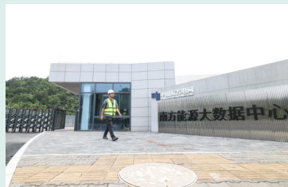
南方电网绿色智慧数据中心
