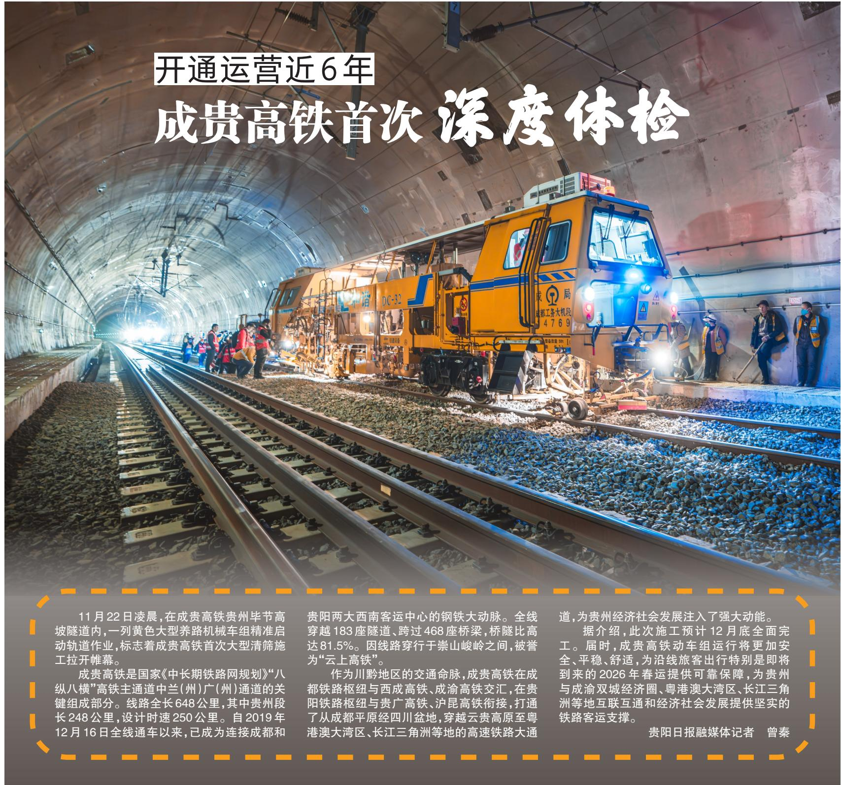
11月22日凌晨,在成贵高铁贵州毕节高坡隧道内,一列黄色大型养路机械车组精准启动轨道作业,标志着成贵高铁首次大型清筛施工拉开帷幕。
