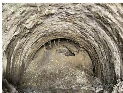
◀上下库连接公路交通洞贯通现场
